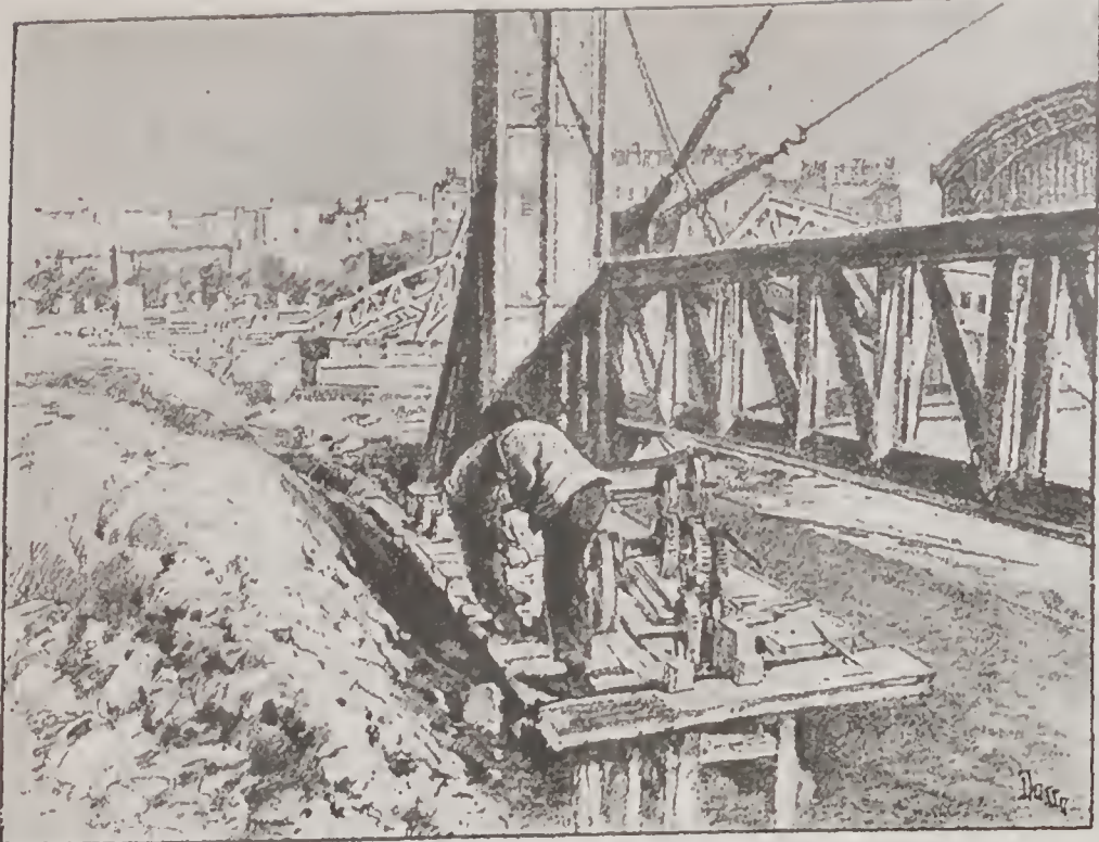
AU CHAMP-DE-MARS. — Mise en marche de la troisième travée de la galerie de 30 mètres.
